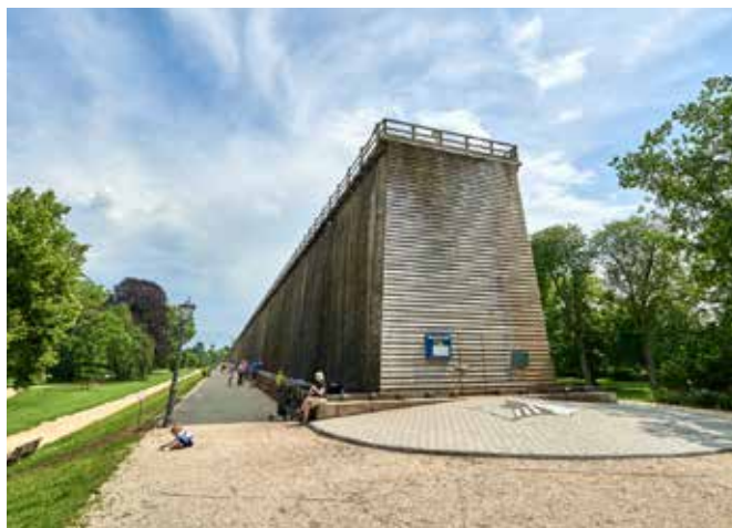
Gradierwerk, Osnabrücker Land
