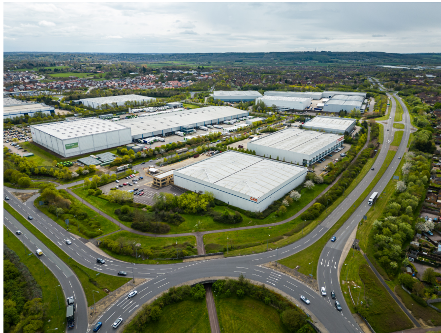
Die Photos zeigen die ersten, auf Ebene der Zweckgesellschaft, vertraglich gesicherten Logistikimmobilien
